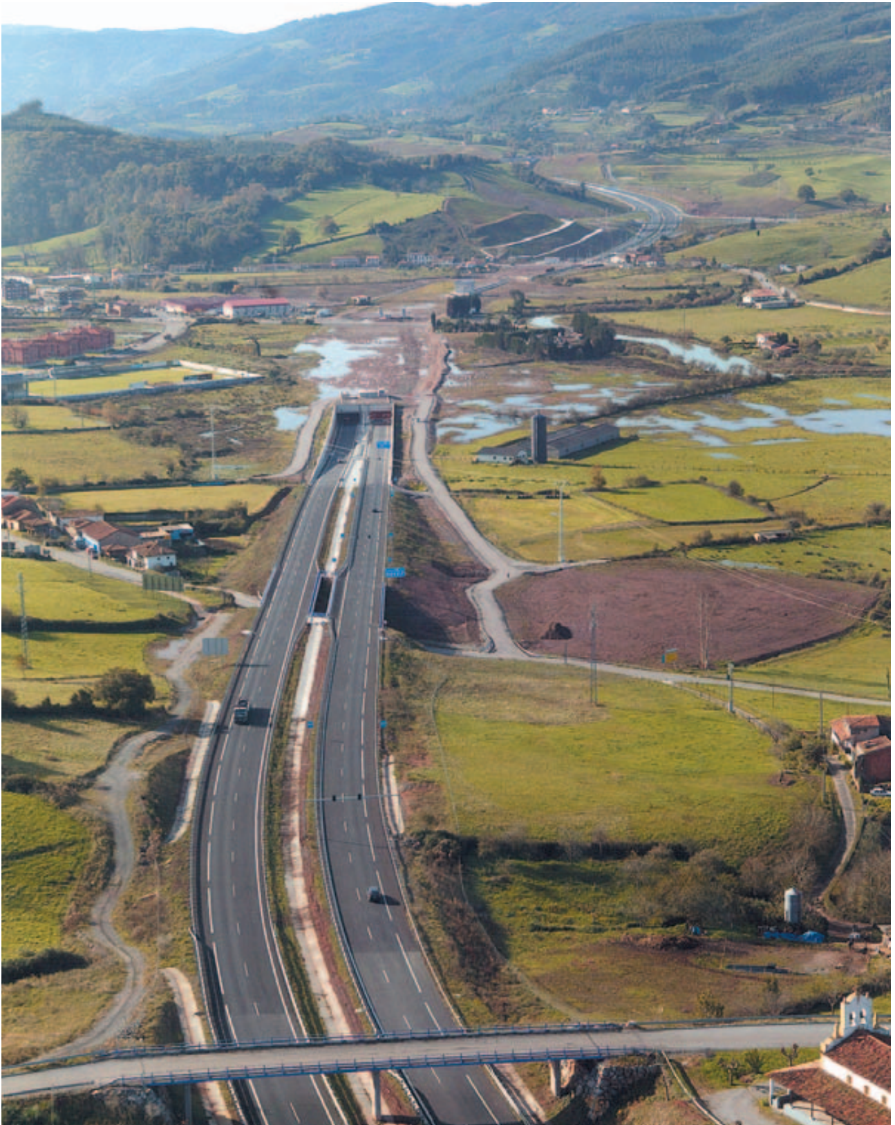
Túnel de la ría de Villaviciosa (Asturias)
