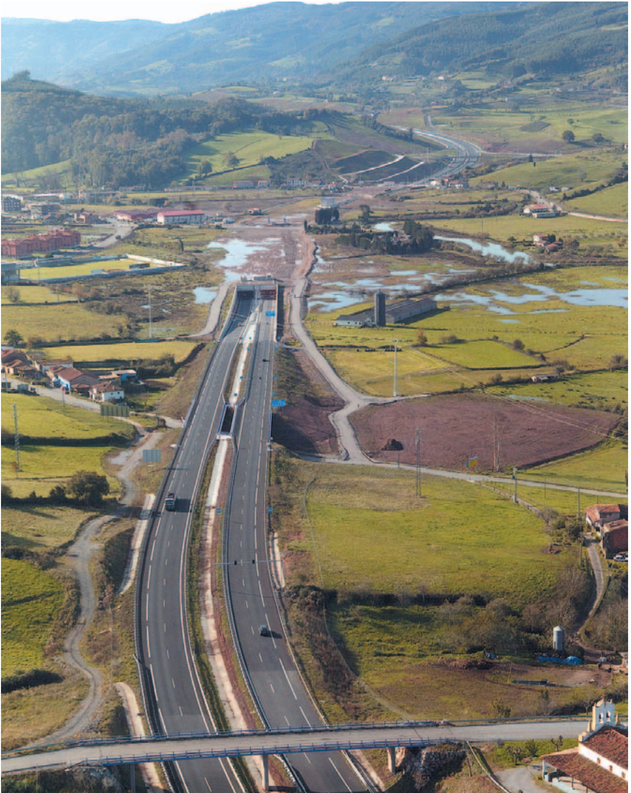
Tunnel under the Ría de Villaviciosa (Asturias)
