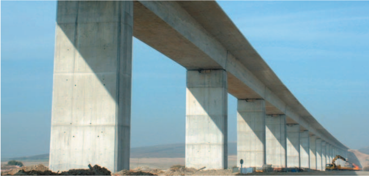
AVE, Puente Genil section (Córdoba)
