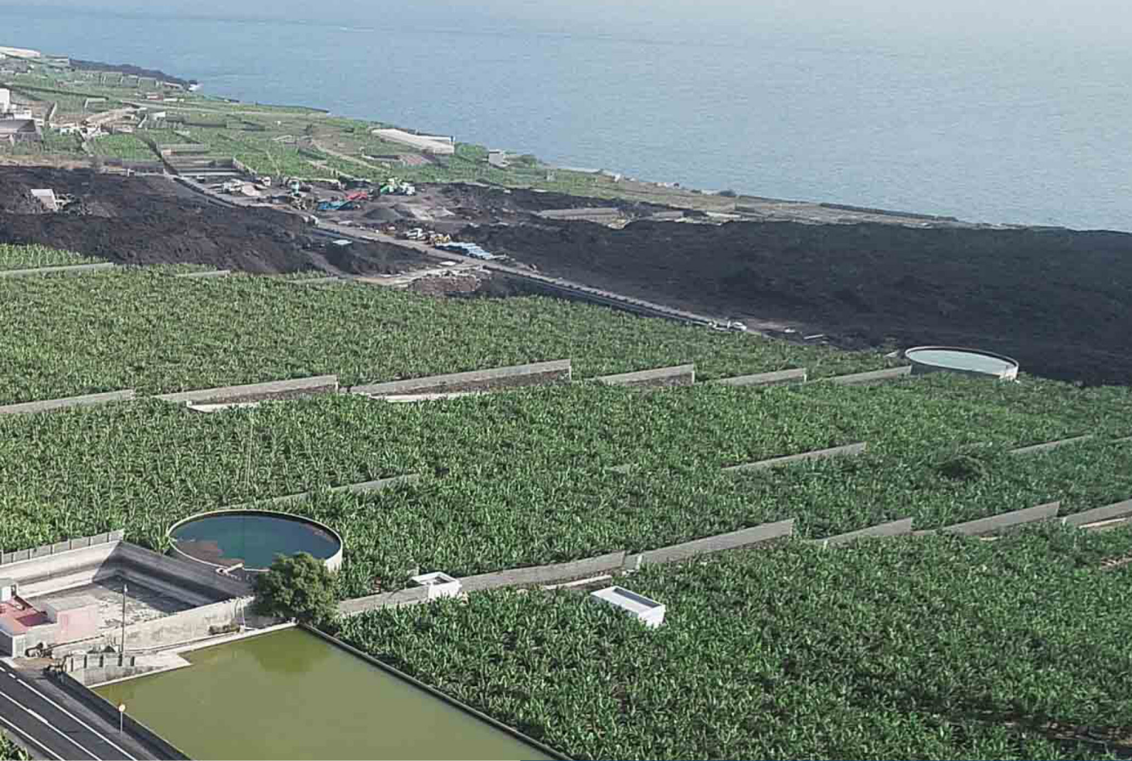
CARRETERA DE LA PALMA CONSTRUIDA SOBRE LA LAVA, ESPAÑA - © DRAGADOS
