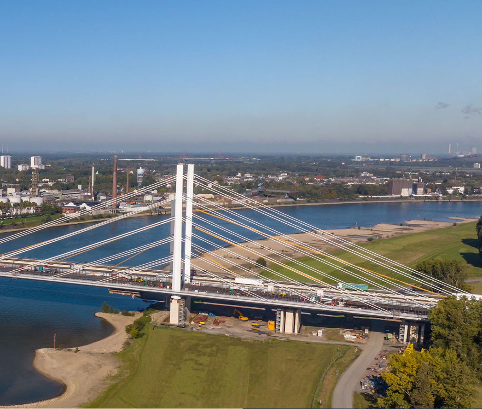
PUENTE DE LA A40 SOBRE EL RIN EN DUISBURGO, ALEMANIA - © HOCHTIEF
