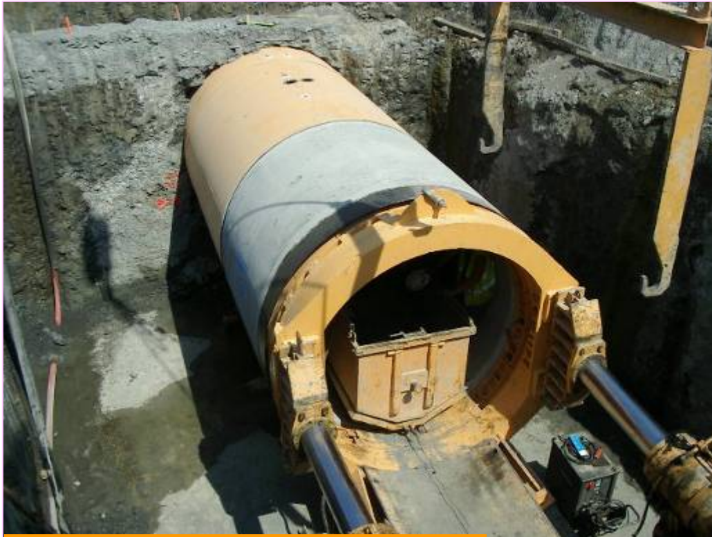
Soterramiento LAT 400kV
