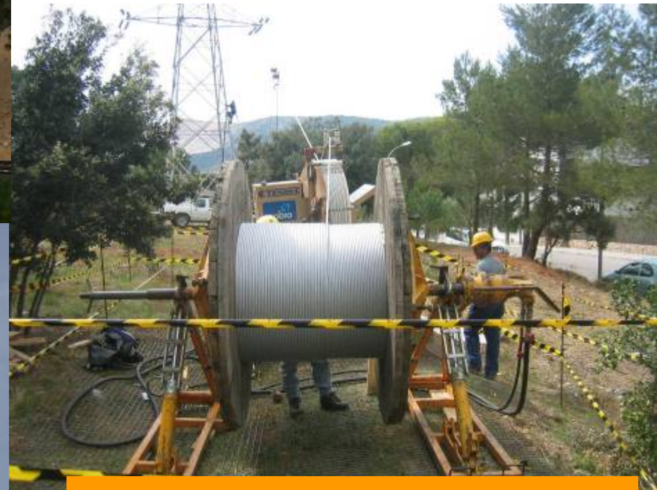
Tendido de Fibra Optica OPGW
