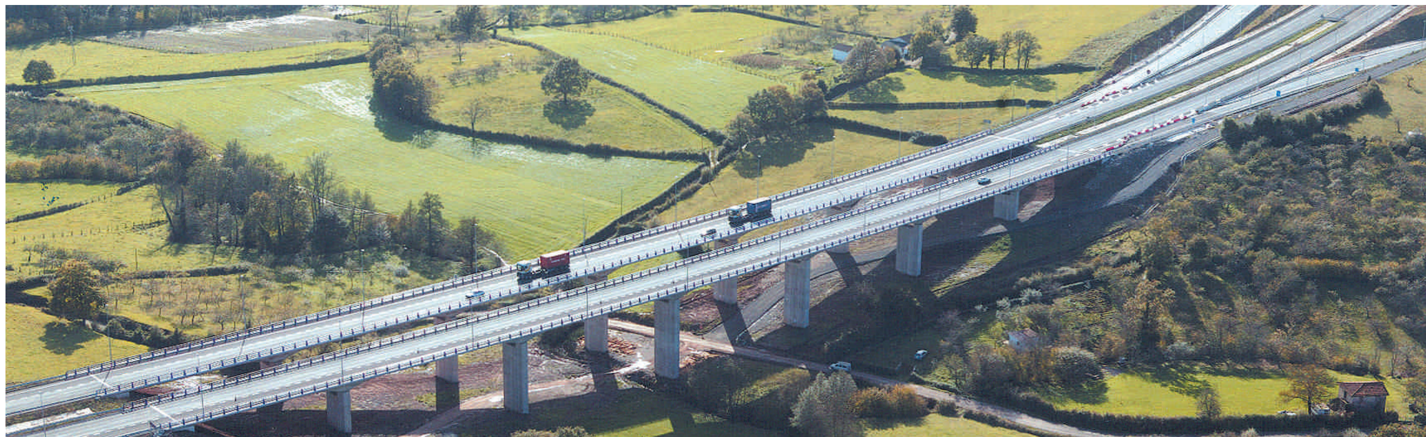
Viaducto de Grases (Asturias)
