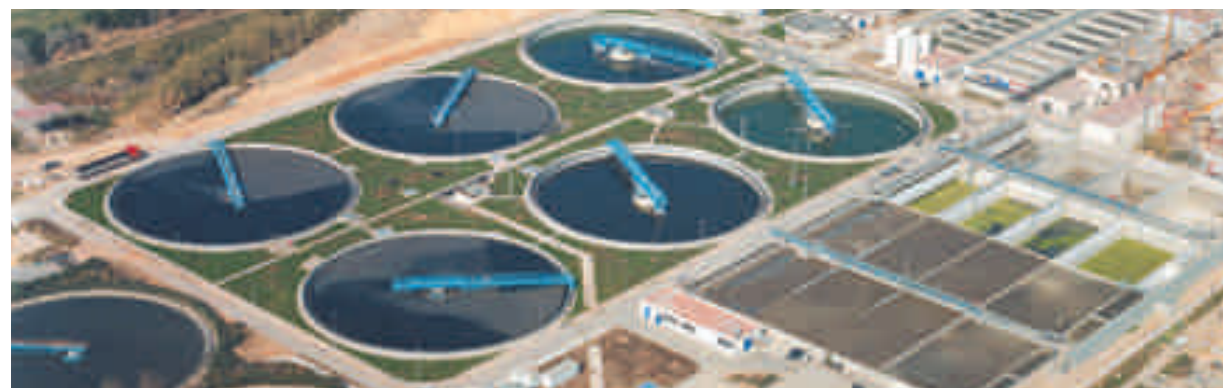
Ampliación de Depuradora de Aguas Residuales, Valencia
