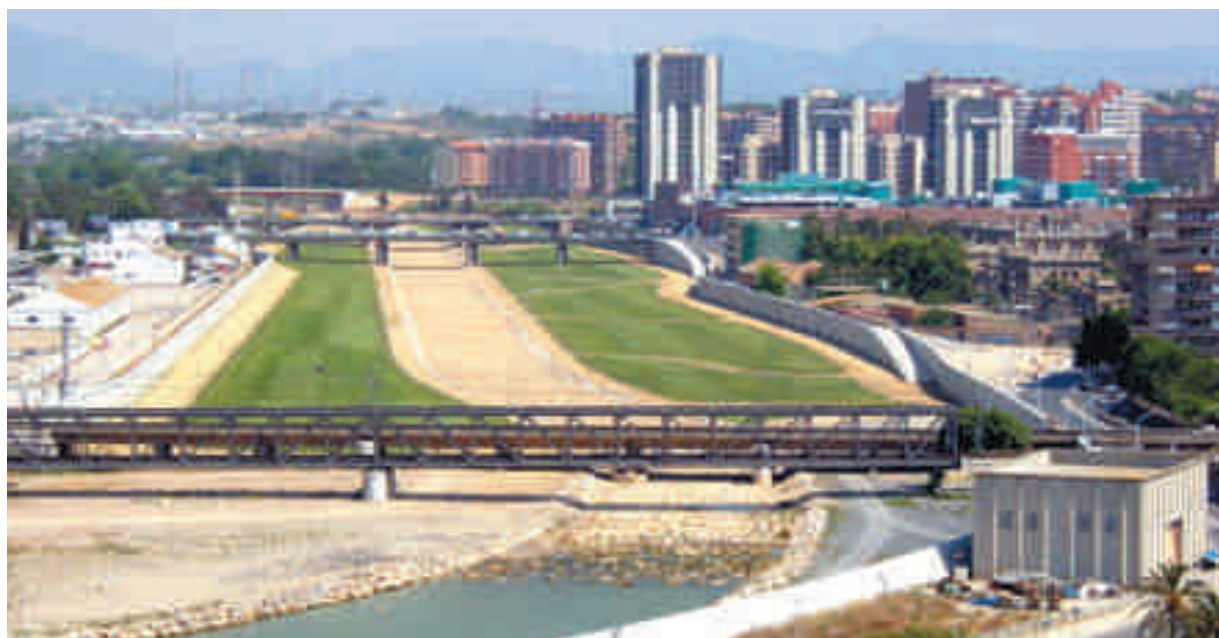
Remodelación del cauce del río Francolí, Tarragona
