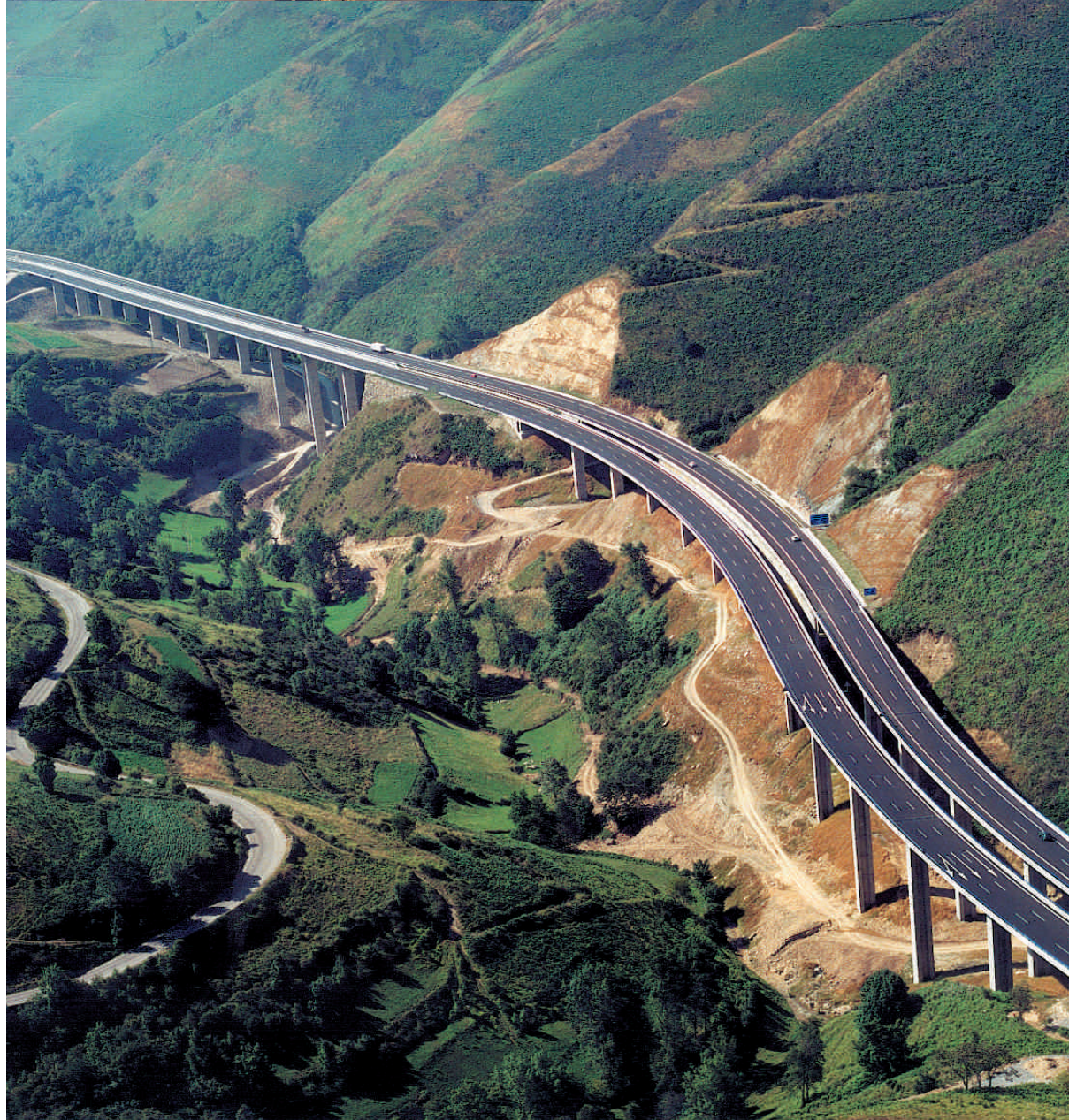
Autovía del Noroeste A-6 (Lugo)
