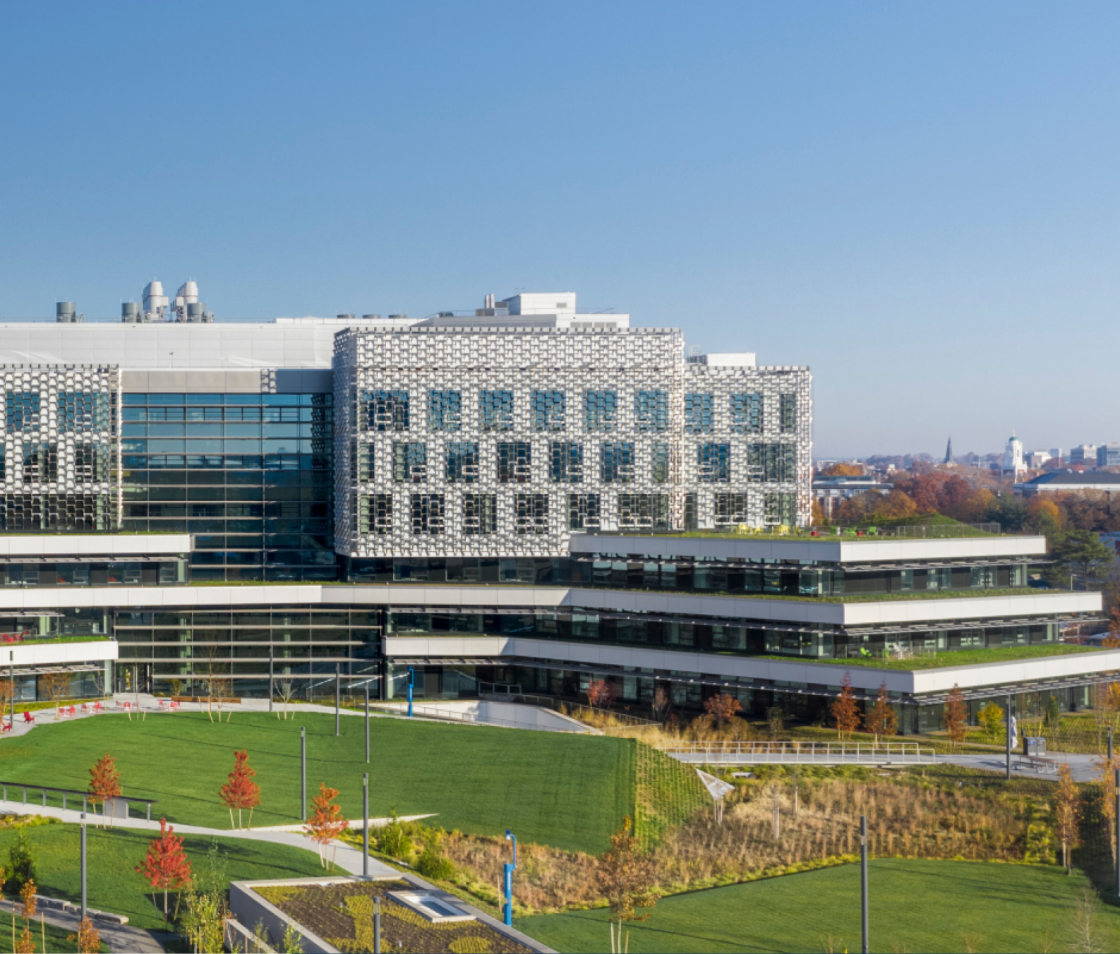
COMPLEJO DE CIENCIAS E INGENIERÍA DE LA UNIVERSIDAD DE HARVARD, BOSTON, EE.UU. (TURNER) - © BRAD FEINKNOFF
