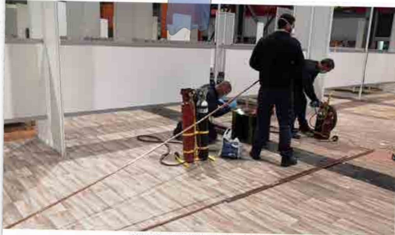
Montaje del nuevo sistema de IFEMA / GRUPO COBRA
