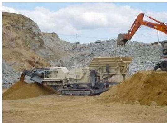
Debido a la generación de tierras excedentes de la excavación existente en la obra y al ser éstos primordialmente piedra, se decide reutilizar dichos materiales en lugar de su traslado al vertedero.
