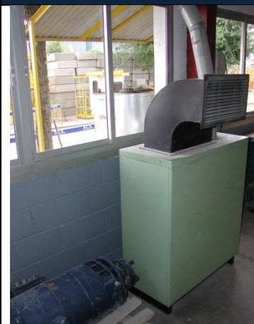
Los parques de maquinaria disponen de calderas de calefacción en las diferentes naves. Todas ellas utilizan combustibles fósiles para su funcionamiento, en concreto, gasóleo C.
