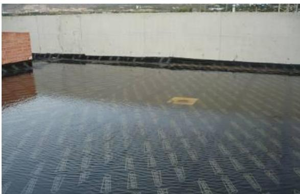
El agua utilizada para la prueba de estanquidad de las cubiertas se reutilizó, mediante el uso de bombas, para el llenado de la tubería de hormigón y realizar la prueba de estanquidad de dicha conducción.
