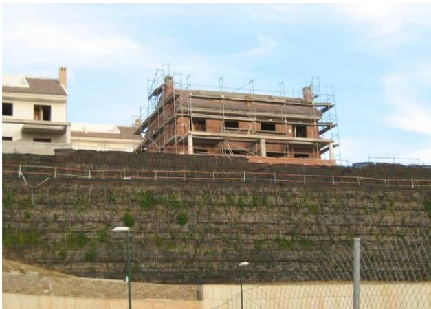
La medida adoptada consiste en sustituir una estructura de hormigón armado, proyectada para la concreción de los patios de vivienda, por un muro ecológico, basado en un sistema de tierra armada y compactada.
