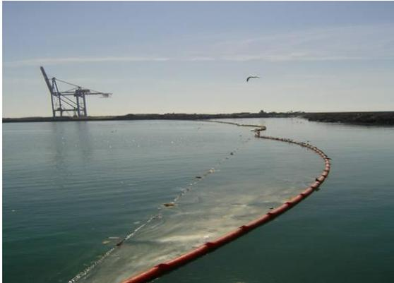
Con motivo de los trabajos para la construcción de la explanada, y como consecuencia del vertido de materiales de relleno procedentes de préstamo para su realización, se venía observando que en ocasiones este material contenía algunos trozos de maderas y plásticos que finalmente flotaban y se dirigían a la dársena del puerto, con el consiguiente ensuciamiento y posibles impactos de estos objetos con pequeñas embarcaciones.
