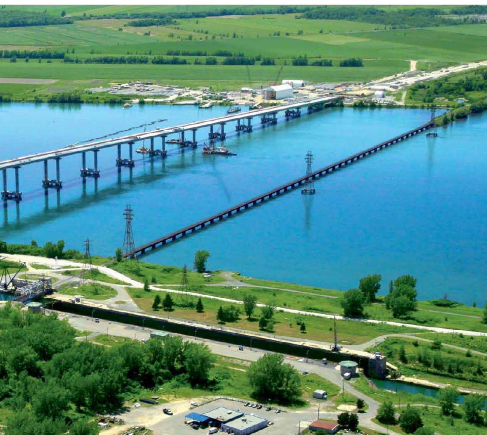
Foto: A30-Nouvelle Autoroute (Montreal, Canadá).
