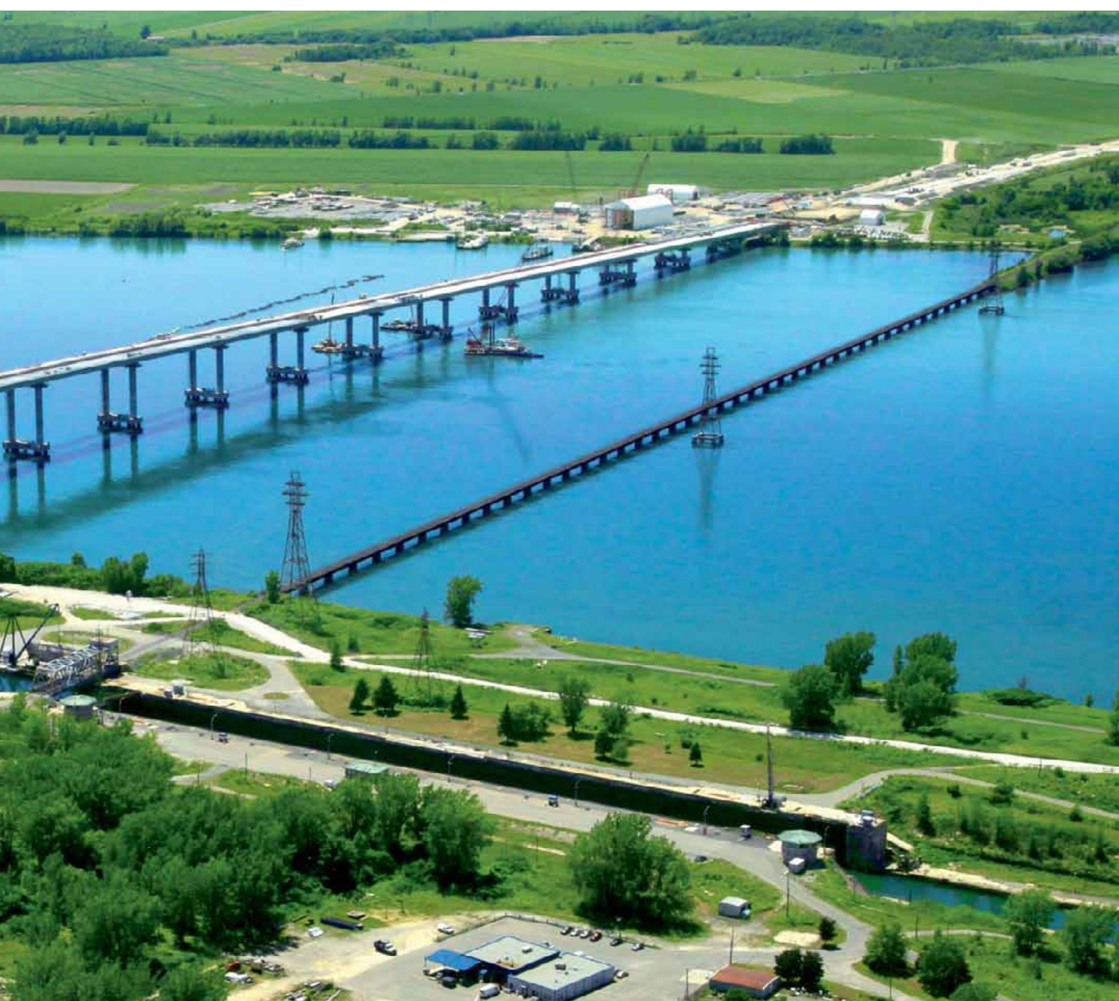
Cover photo: A30-Nouvelle Autoroute (Montreal, Canada).
