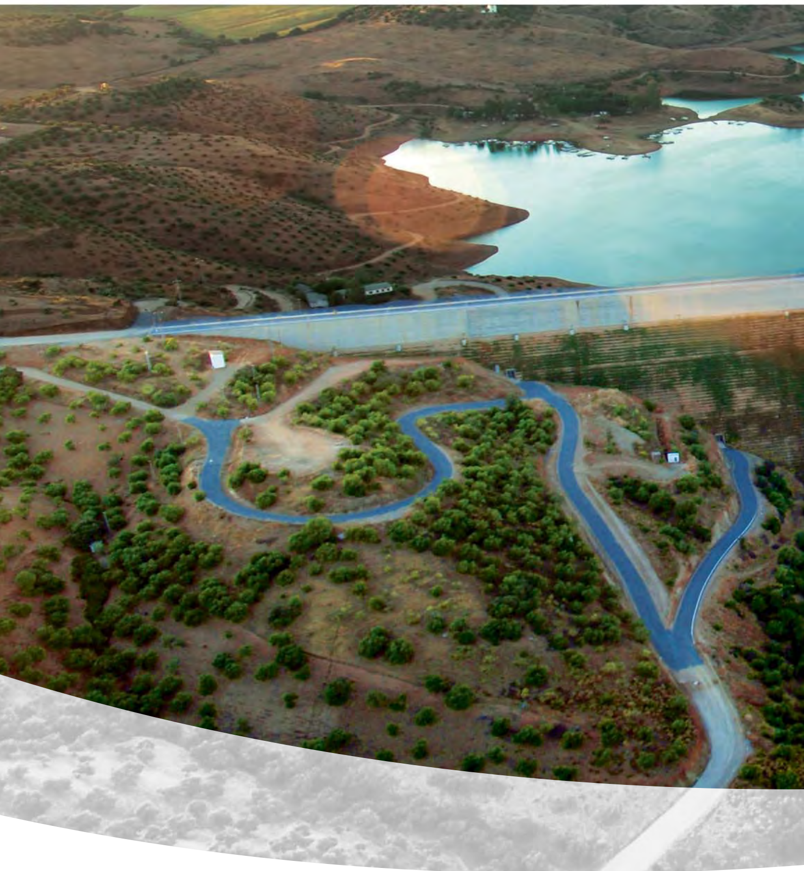
Foto: Presa de la Breña II en Almodóvar del Río (Córdoba, España).
