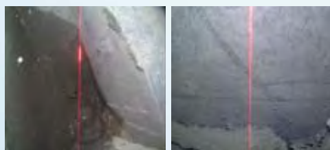
Robot inspeccionando el revestimiento de dovelas de un túnel y ejemplo de las imágenes captadas por las cámaras.
