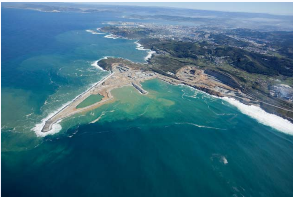
Nuevas Instalaciones Portuarias en construcción en Punta Langosteira (Vista Aérea).
