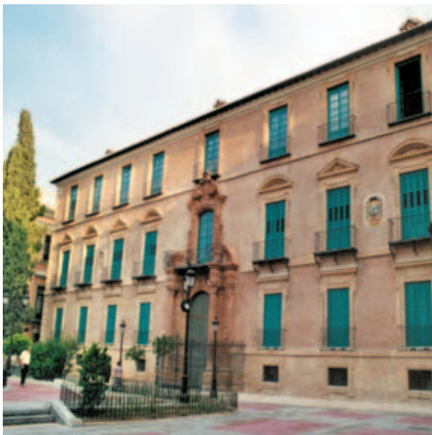
Rehabilitación Palacio Episcopal de Murcia
