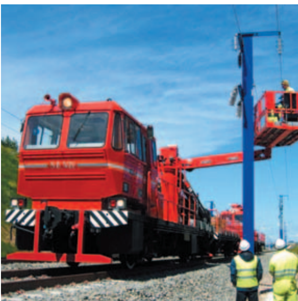
Mantenimiento red eléctrica ferroviaria
