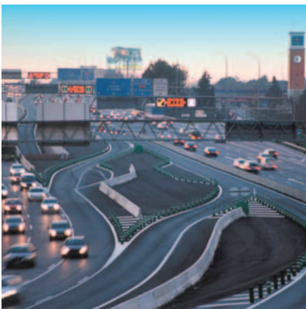
Sistemas de control Bus VAO en N-VI (Madrid)
