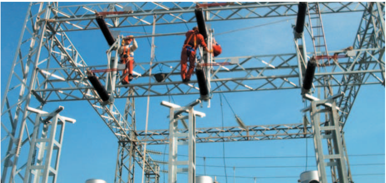
Mantenimiento de la red eléctrica
